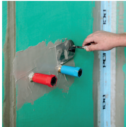
Auch zum Abdichten der Wasserzuleitungen mit der Dichtmanschette PCI Pecitape 10 x 10 wird zunächst ausreichend viel Abdichtungsmaterial vorgelegt...
