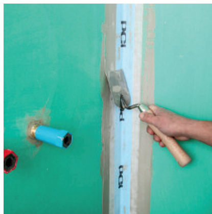
... und nachfolgend mit leichtem Druck eingebettet.
