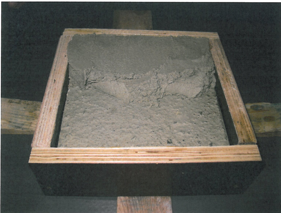
Bild 2 Auftrag von redstone - Sperrputz auf den mit redstone - Spritzbewurf versehenen Prüfkörper
