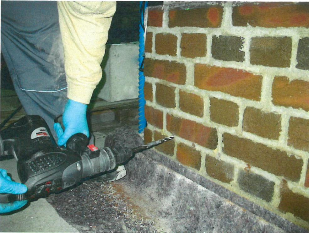
Bild 1 Anlegen der Bohrungen
