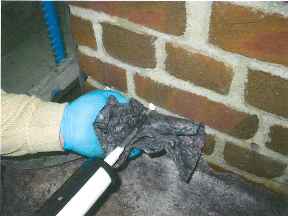
Bild 3 Applikation von *Secco Horizontal Sperre*
