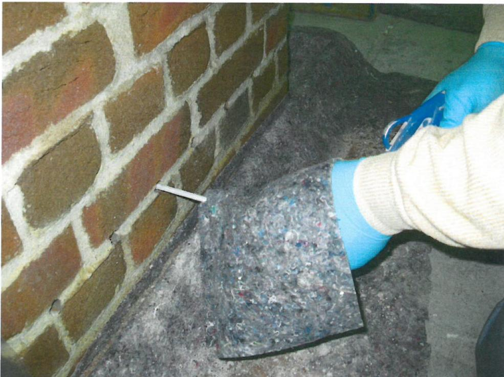
Bild 2 Ausblasen der Bohrlöcher
